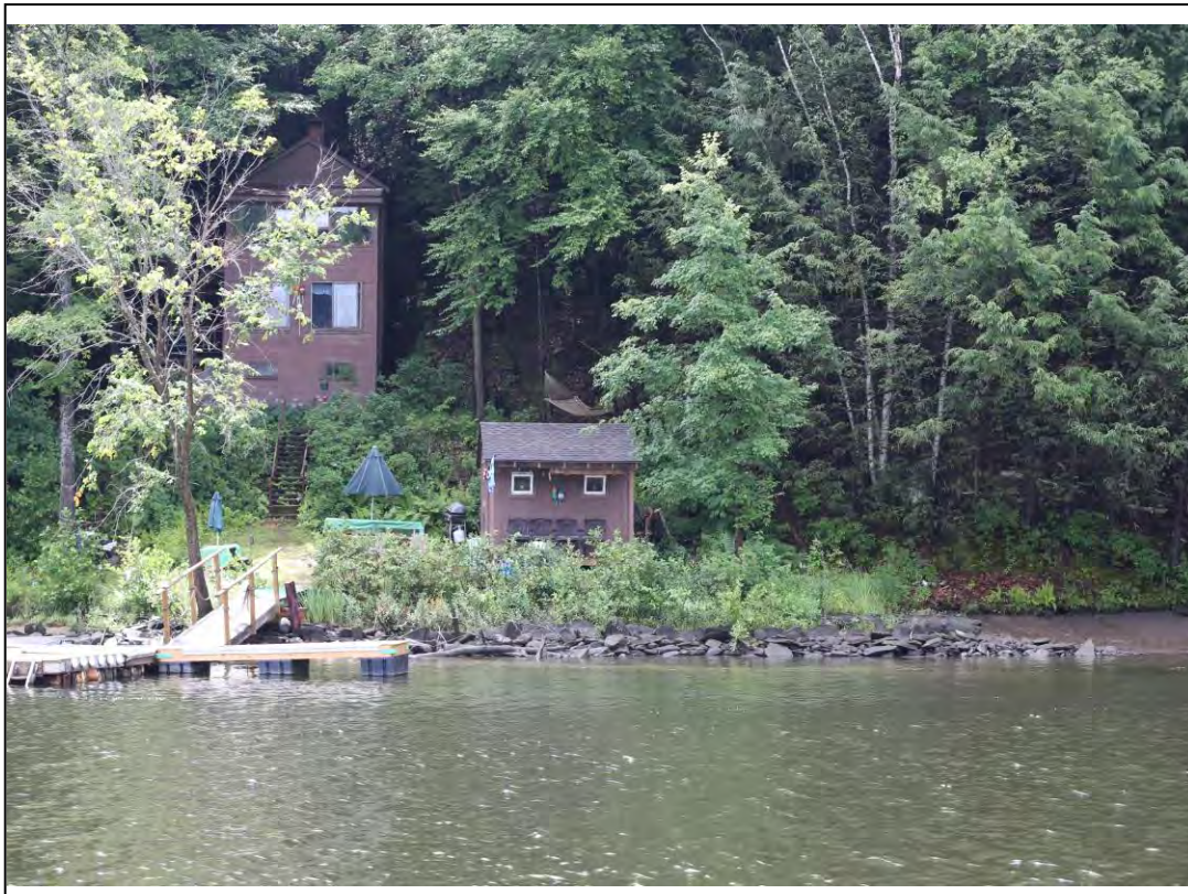
Photo 48: Camp 7E Post Construction 2014.
